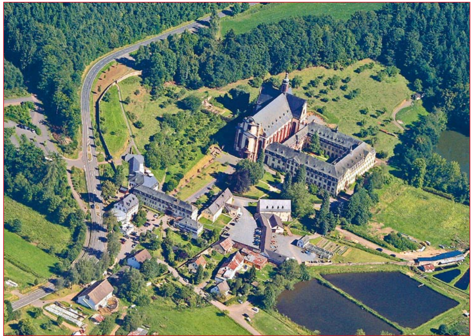
CO 2 -neutrale Wärmeversorgung aus Biomasse für Kloster, Basilika und Nebengebäude
